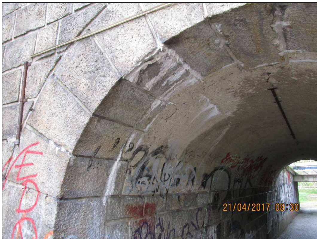
Obr. č. 9 - detail podélných trhlin v klenbě u pravého čela - průsaky vody doprovázeny tvorbou vápenných usazenin
