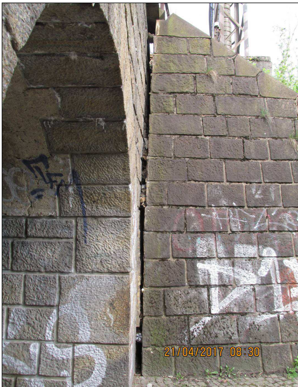
Obr. č. 9 - odtržené mostní křídlo - pravá strana objektu směr Kuřim
