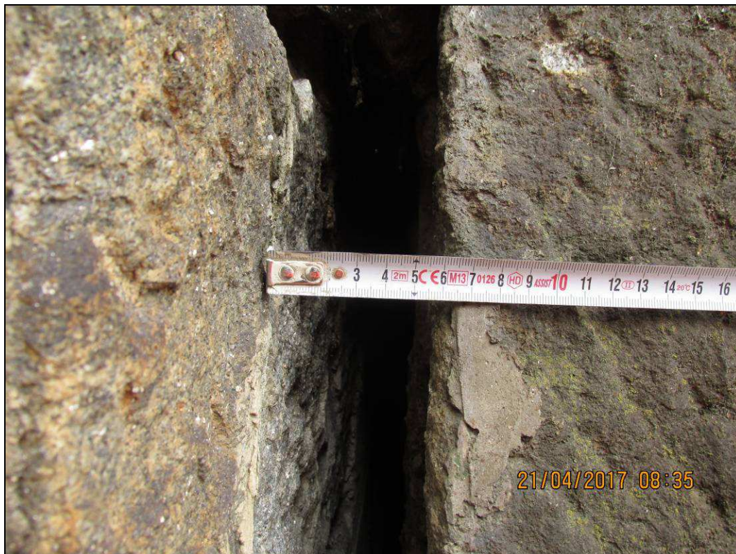
Obr. č. 9 - odtržené mostní křídlo - detail
